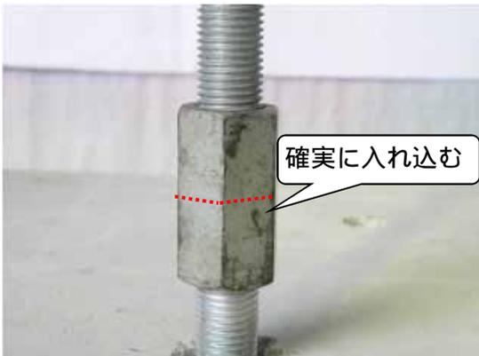
おねじの場合はボルトのネジに適合する
