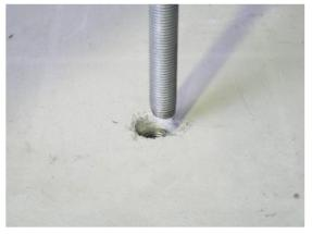
① あと施工アンカーが内ネジの場合、 適合サイズのボルトをねじ込みます。
