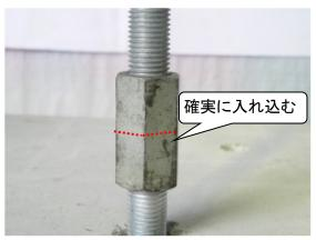
② おねじの場合はボルトのネジに適合する カプラを取り付けセンターシャフトを ねじ込みます。
